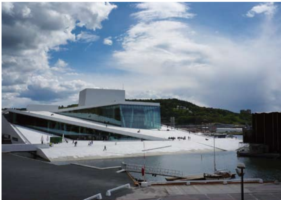
Obr. 2. Nová budova opery na pobřeží Oslofjordu.
